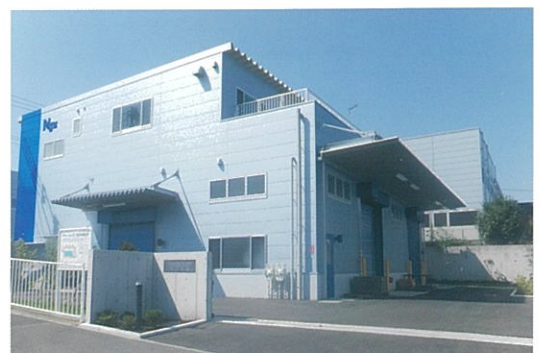
新設第二工場
